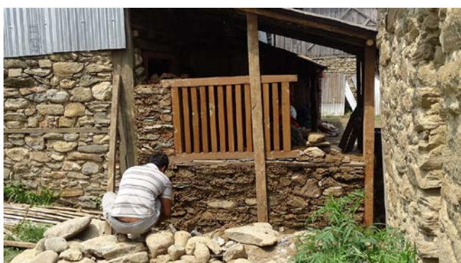
Le mur de la cuisine annexe
