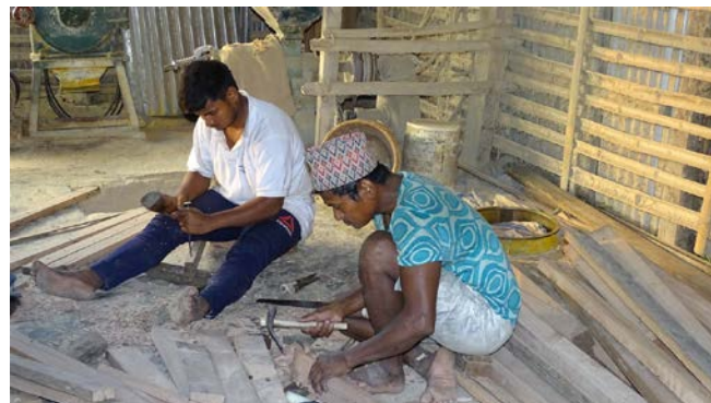
Les menuisiers au travail c'est du fait main
