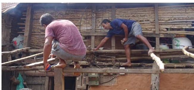
Construction de la terrasse couverte
