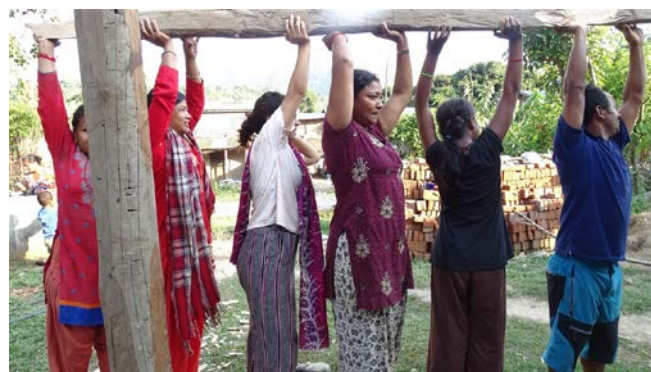
Délicat montage de la poutre principale de 12 mètres
