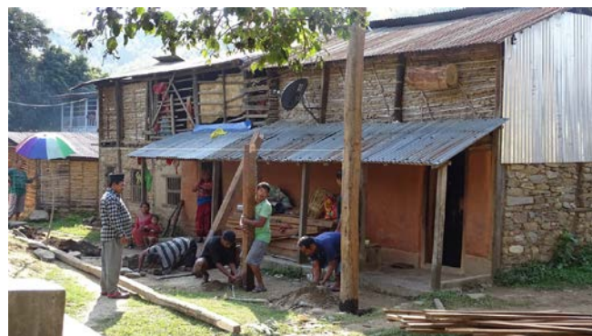
La maison avant l'agrandissement, et les premiers travaux.
