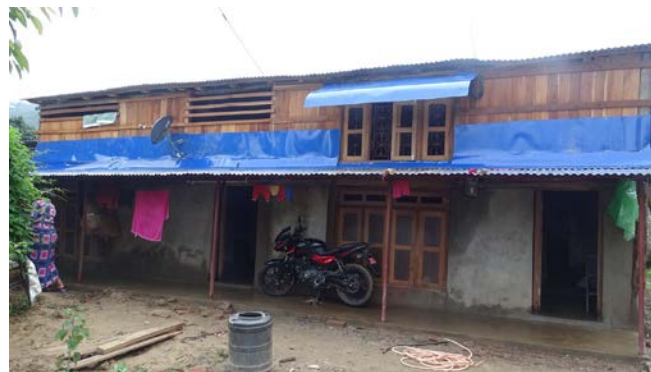
Fin des gros travaux
