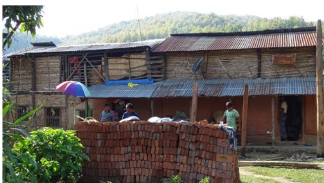
Début des travaux 9 Mai 2020
