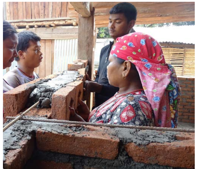
Un peu de fer à béton
