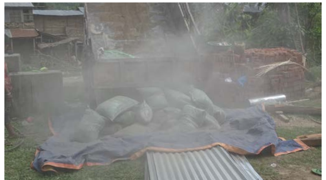
Ciment, briques et tôles
